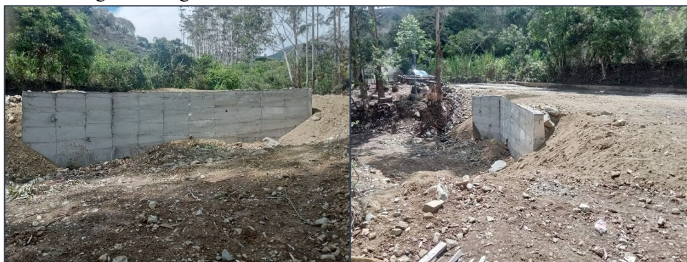
Imagen 09: Construcción de muro
